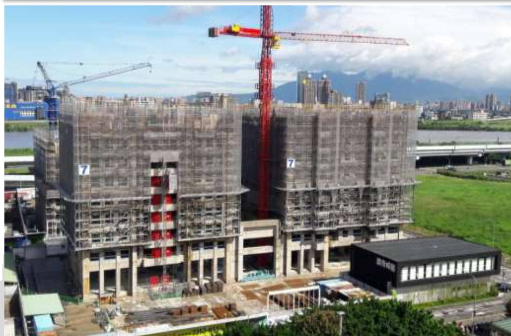
目前施工照片
