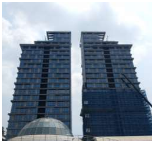
目前施工照片-1
