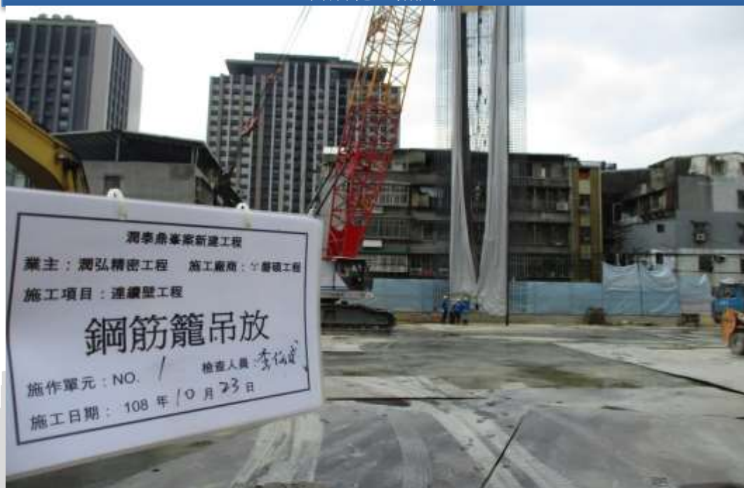
目前施工照片
