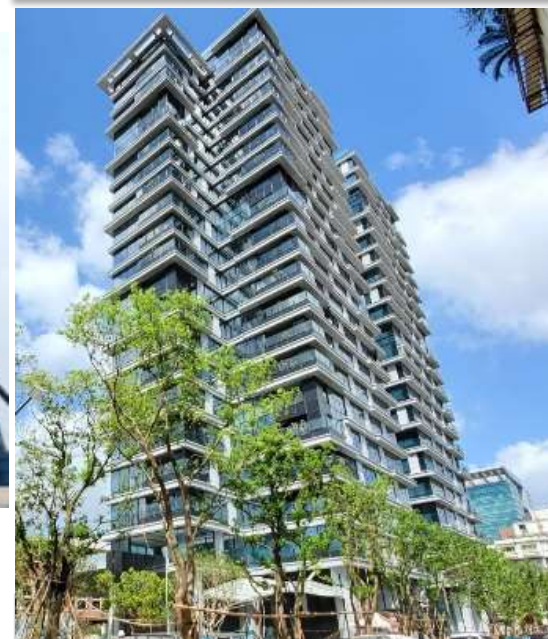
目前施工照片-2
