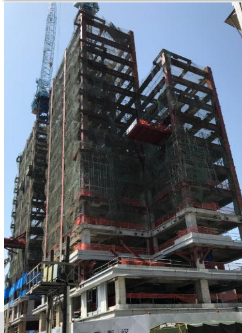
目前施工照片-1
