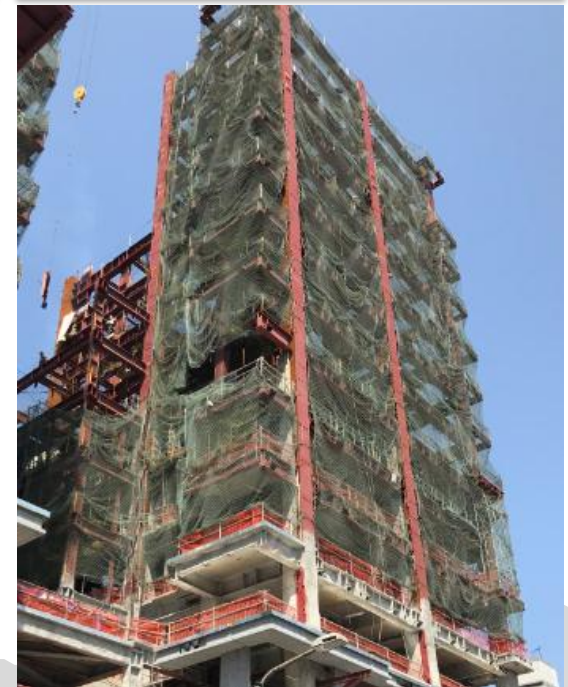
目前施工照片-2
