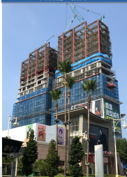
目前施工照片-1
