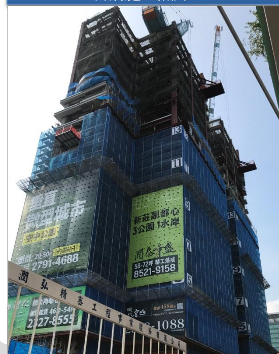
目前施工照片-2
