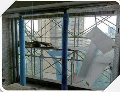
圖說: 牆面模板未拆乾淨
