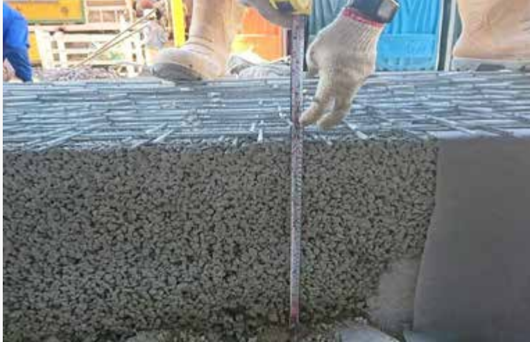
綠建築施工照片 - 潤泰奇岩透水混凝土
