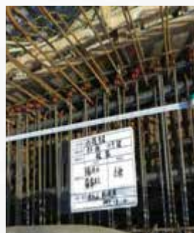
樑 — 鋼筋品質查驗作業
