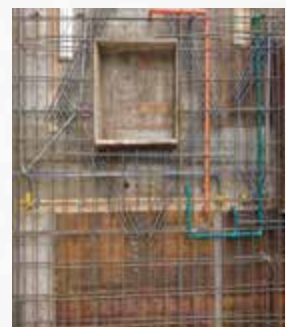
牆 — 鋼筋品質查驗作業
