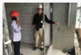
室內水管 試壓參觀
