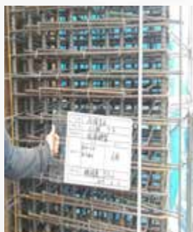
柱 — 鋼筋品質查驗作業
