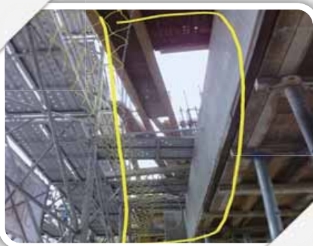
圖說: 模板作業平台踏板開口滿鋪固定改善作業
