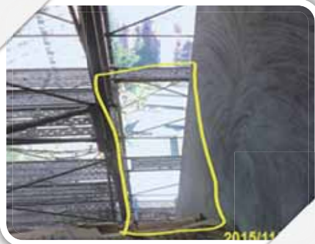
圖說:外牆施工架水平踏板開口裸露，加強安全防護設置
