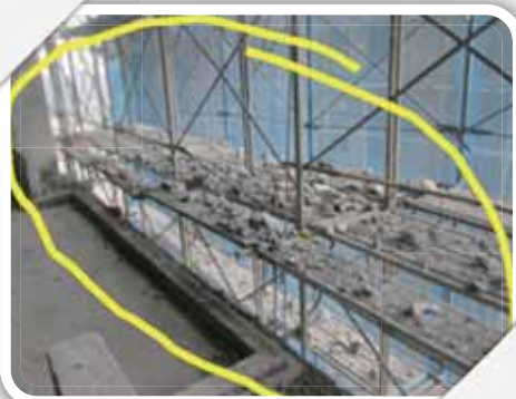
圖說: 加強清理施工架上混凝土塊及作業區管制設施
