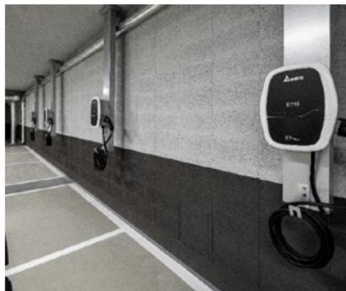
潤泰創新積極投入推動電動車友善社區發展，新建案在規劃初期均預留電動車充電管件與線架的安裝位置，並研發電動充電樁倒吊安裝方式，避免破壞停車場地坪防水，於 2021 年起完工之建案皆完成電動車充電線架安裝。目前更與相關廠商開發新型態的電動車充電樁安裝工法，提供更便利與低成本的安裝選擇，藉此提升住戶使用電動車的意願度。公司於 2022 年宣布與共享機車品牌攜手合作，計畫推出建案專屬之社區電動機車服務，提供用戶低碳排的交通選擇。
