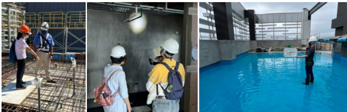
右圖：樓板澆灌參觀（潤泰大安富陽）；中圖：試水暨試壓參觀（潤泰央北）；左圖：屋頂版防水試水參觀（潤泰鼎峯）
